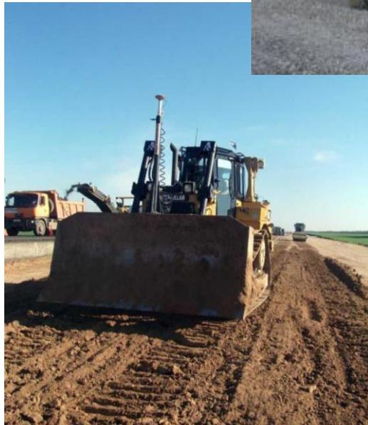
Применение техники с 3D-системами автоматического управления на основе технологий высокоточного позиционирования GPS/ГЛОНАСС:
